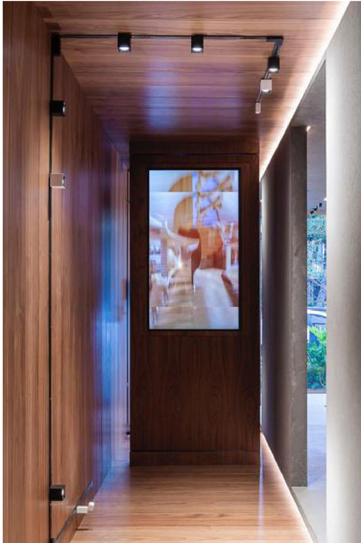
Das System besteht aus einer fortschrittlichen 6 mm dicken 48-V-Stromschiene. Sie durchzieht den Raum und nimmt die einzelnen Lichteinheiten auf. Die unterschiedlichen elektrischen Verbindungen werden einfach mittels Magneten auf der Stromschiene positioniert, so lassen sich die verschiedenen Module einfach und leicht miteinander verbinden.
